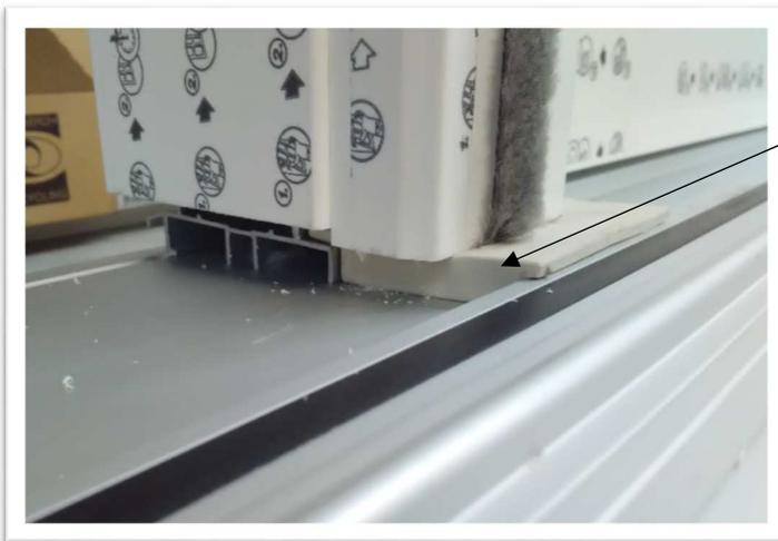
Il profilo di chiusura centrale montato sull'anta fissa va a premere sul tampone in gomma.
