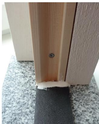
Anche sul bordo verso le spalle, il nastro deve rimanere staccato di circa 5 mm: questa fessura viene riempita, prima della posa del serramento, con il sigillante fluido PosaClima MS PowerFlex 25 che creerà una sigillatura perfetta tra il nastro e la spalla detta "cucitura" (vedi foto).
