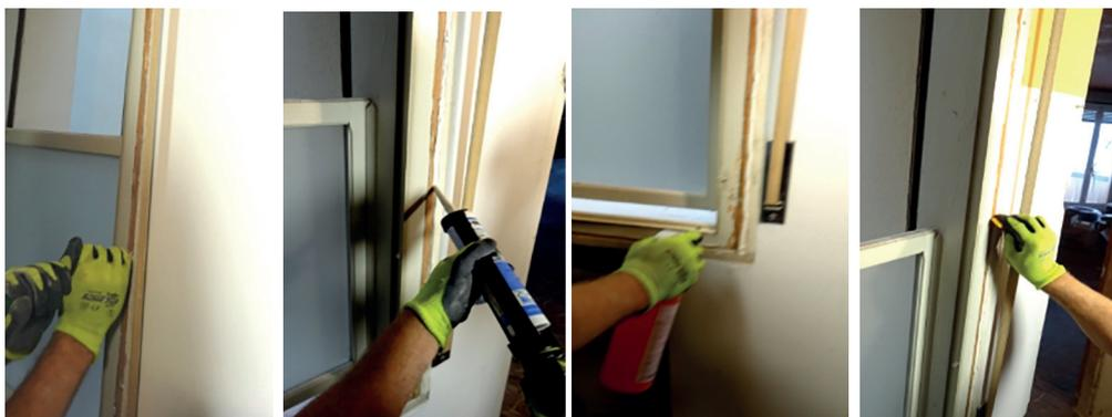
Sequenza della sigillatura del telaio murato con PosaClima MS Polimero
