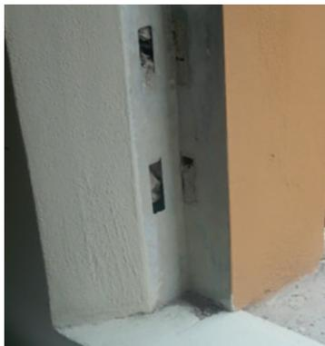
In cantiere eliminare il controtelaio metallico è piuttosto semplice quando si tratta del semplice profilo tubolare da 40 x 20 mm che veniva solitamente utilizzato per montare i serramenti in alluminio: in questo caso ci sono poche zanche da tagliare e il lavoro risulta semplice e rapido.
