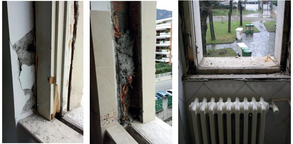
Questa soluzione si complica ulteriormente quando si è in presenza dell'avvolgibile perché talvolta le guide del telo ed il palo di avvolgimento sono fissati direttamente al telaio e rimuovendolo si è poi costretti a ripristinare tutto al nuovo.
