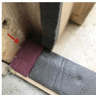
Dettaglio dello spessore da 3 mm da posizionare in corrispondenza dei montanti della porta a finestra.
