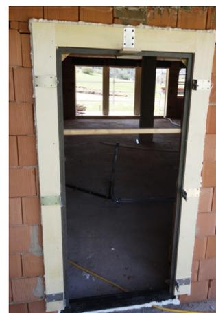
Controtelaio per il fissaggio delle staffe porta-cardini e dell'incontro ferma-scuri. La traversa
