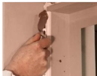
**Attenzione: per una corretta adesione e stabilità del profilo incollarlo tenendo il dentino che coprirà la spalla del controtelaio ben aderente alla stessa.**
