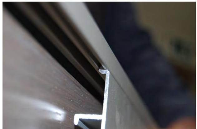
5. Incastrare nel montante il carter di alluminio già tagliato nell'apposita fuga del precedente telaio di alluminio montato.
