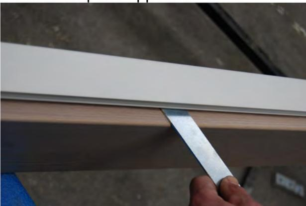
4. Inserire la chiave nelle clips e ruotarla per il fissaggio del telaio.
